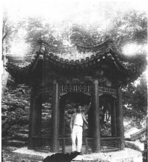
图3 北京 北海凉亭 柱间可以没有墙壁门窗成为凉亭，亦可砌墙安门窗。
